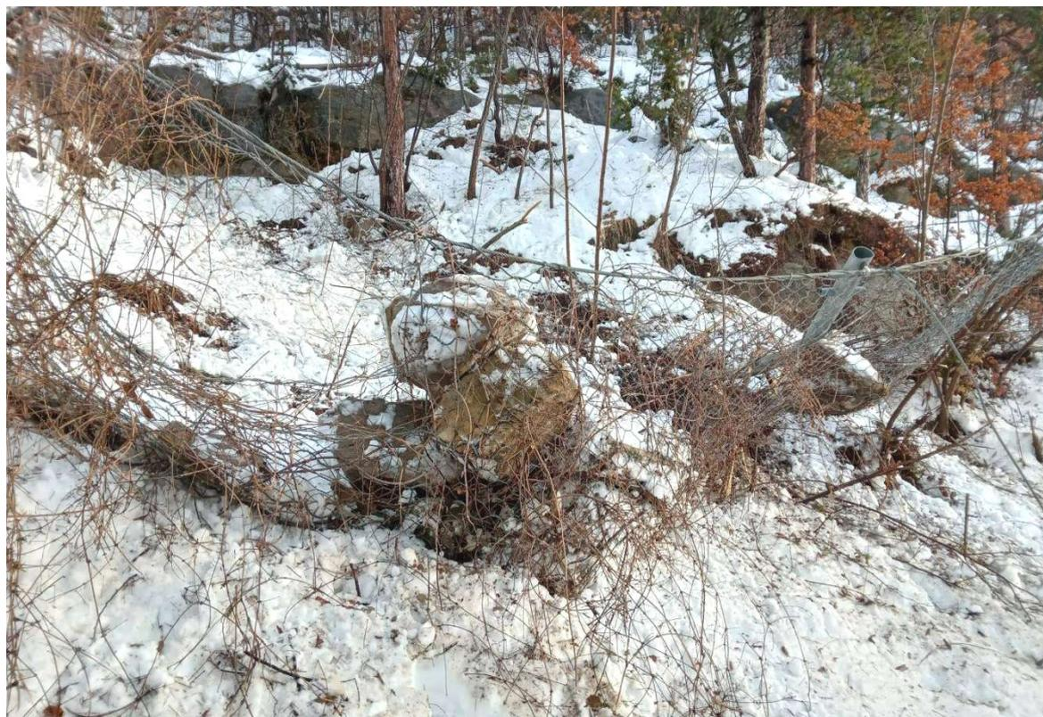
**Foto 2 – Particolare del materiale trattenuto dalla barriera paramassi e del montante della barriera deformato**
