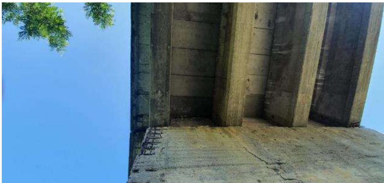
Figura 6 - Vista muro spalla di appoggio ovest
