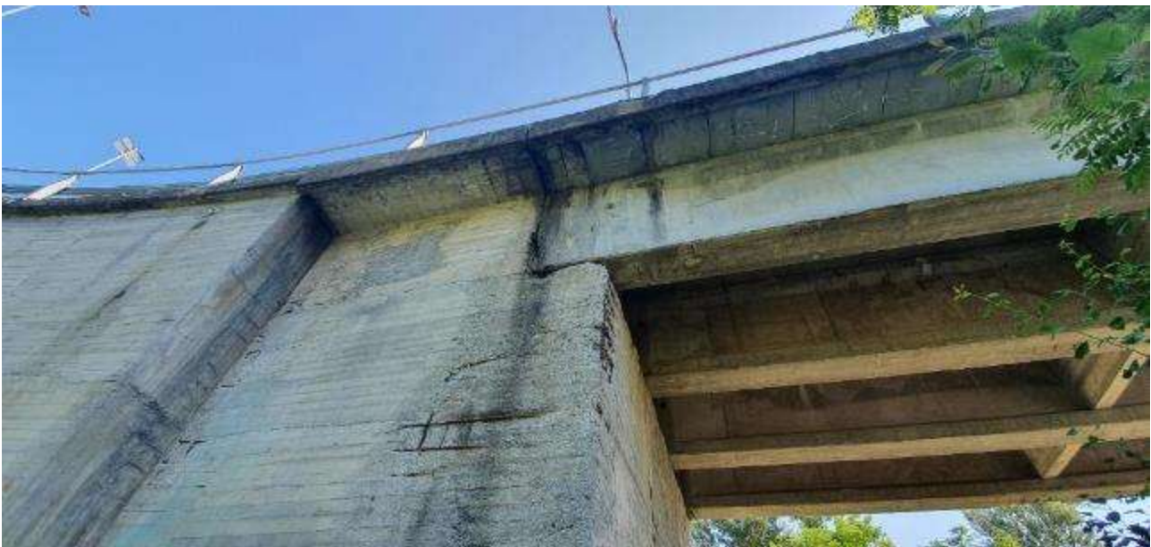
Figura 5 - Vista spalla di appoggio ovest
