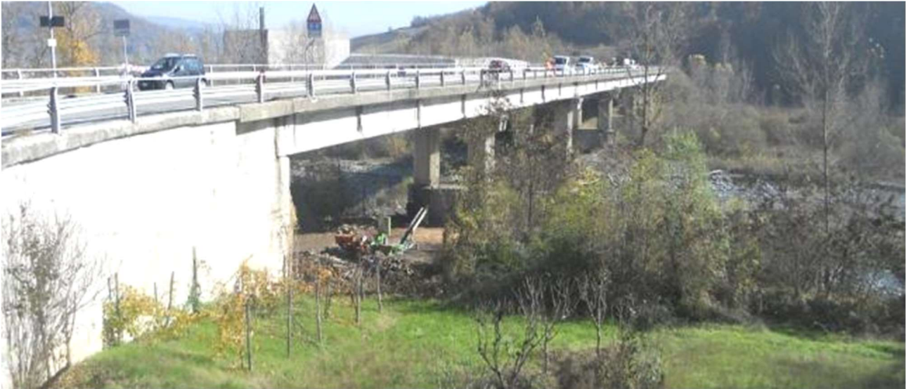
Figura 4 - Vista laterale sud
