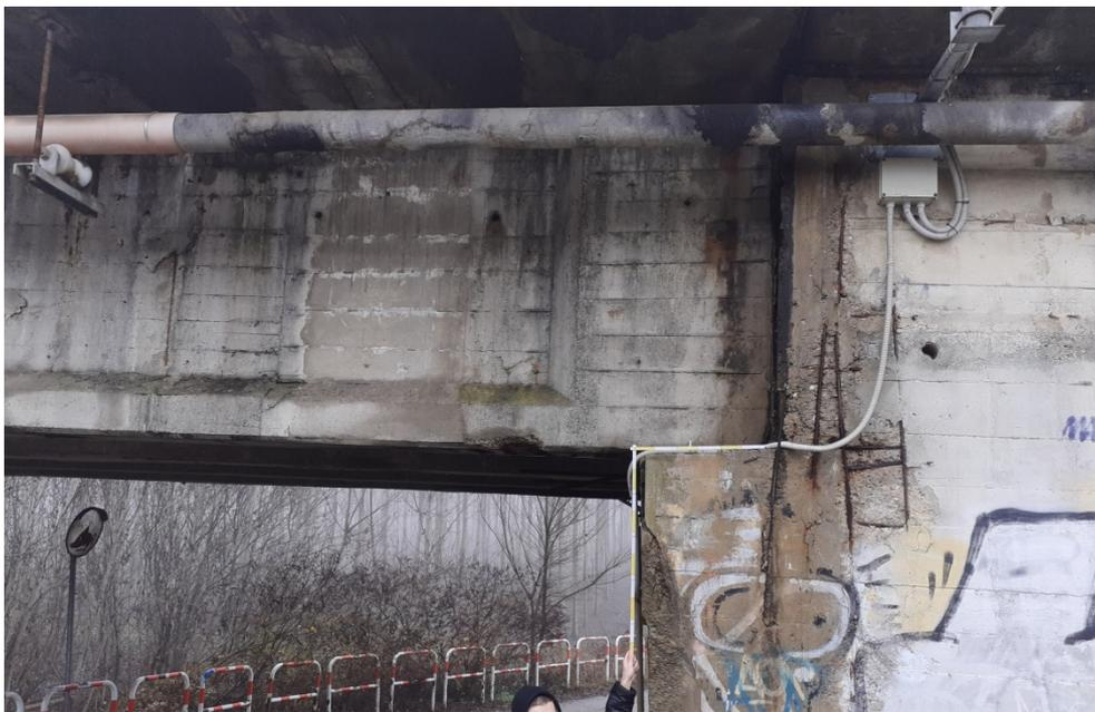
Fig. 2.5 - Spalla e zona appoggio
