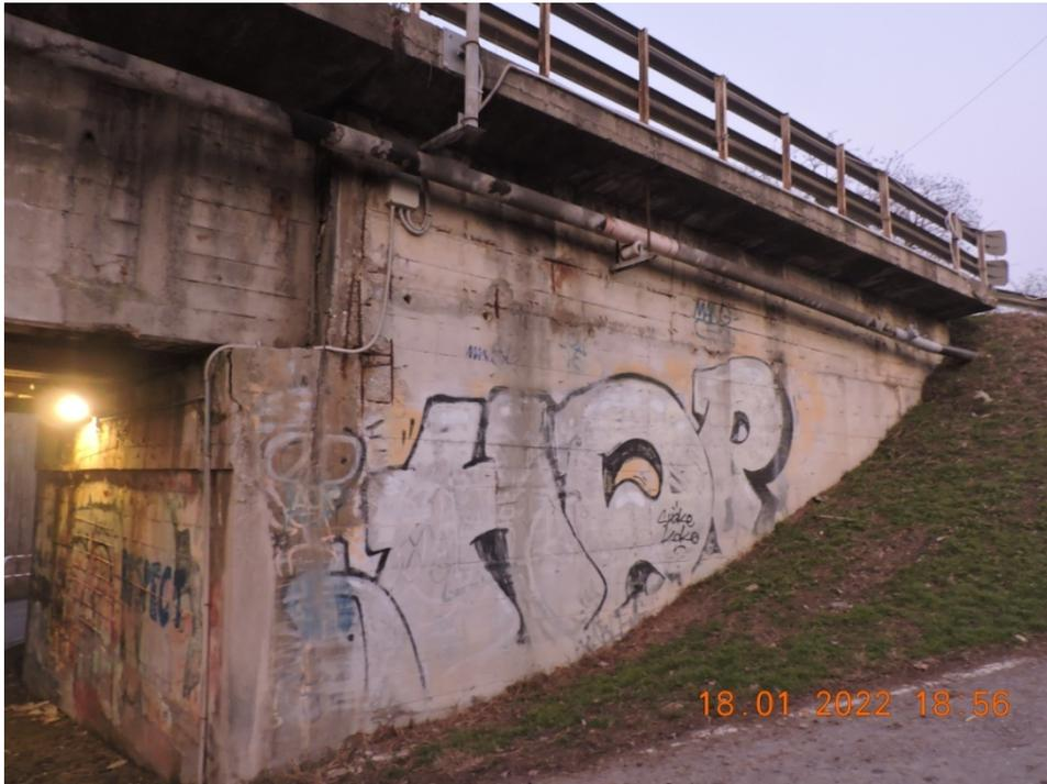
Fig. 5.2 - Il corpo illuminante con l'impianto elettrico da spostare
