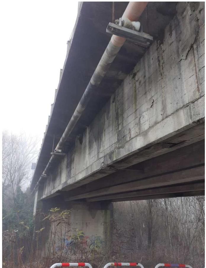
Fig. 5.1 - Tubazione da spostare temporaneamente
