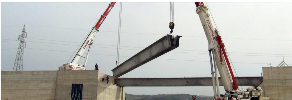
Fig. 4.3 - Esempio di sollevamento di una sola trave nuova a V con due autogru alle estremità
