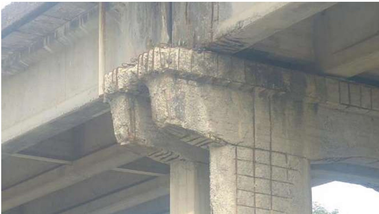
Figura 8 - Vista degrado trave pulvino
