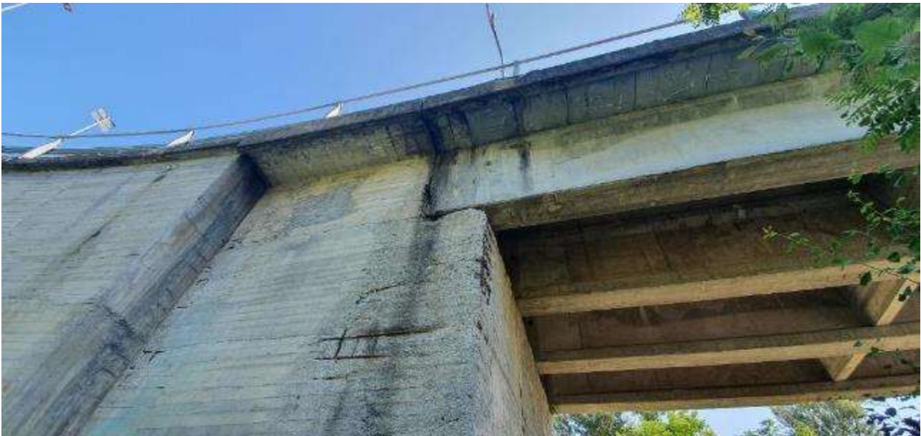
Figura 5 - Vista spalla di appoggio ovest
