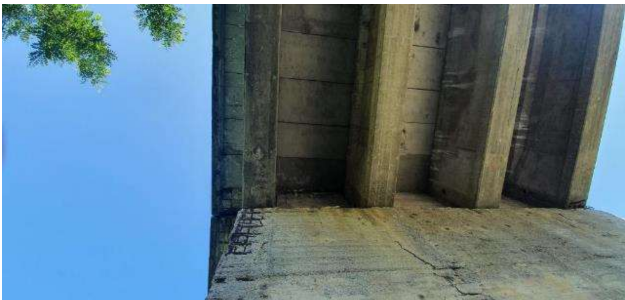
Figura 6 - Vista muro spalla di appoggio ovest
