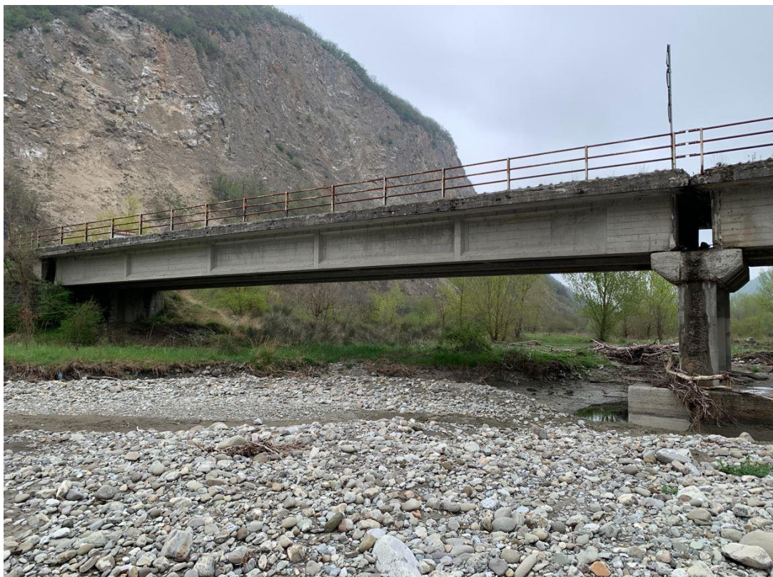
FOTO 2_Vista da lato monte dell'ultima campata prima della spalla
