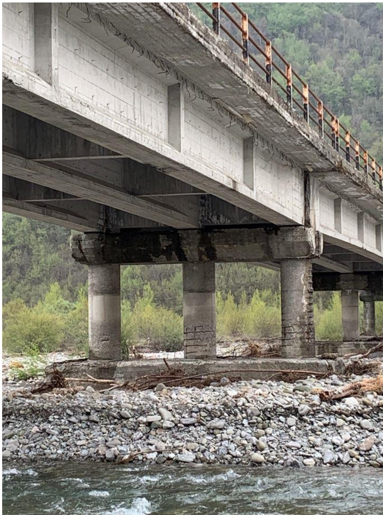
FOTO 5_Dettaglio delle pile centrali
