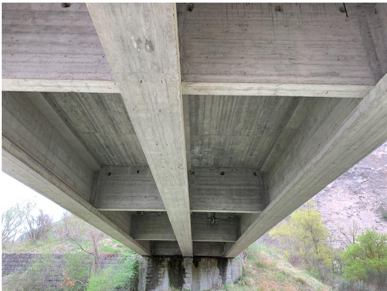
FOTO 6_Vista delle facciate interne dei traversi e delle travi
