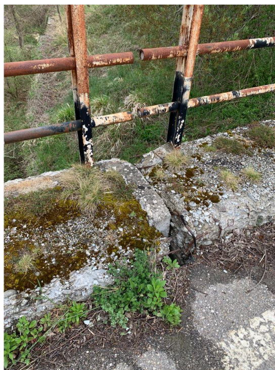
FOTO 7_Vista del parapetto esistente a livello della carreggiata
