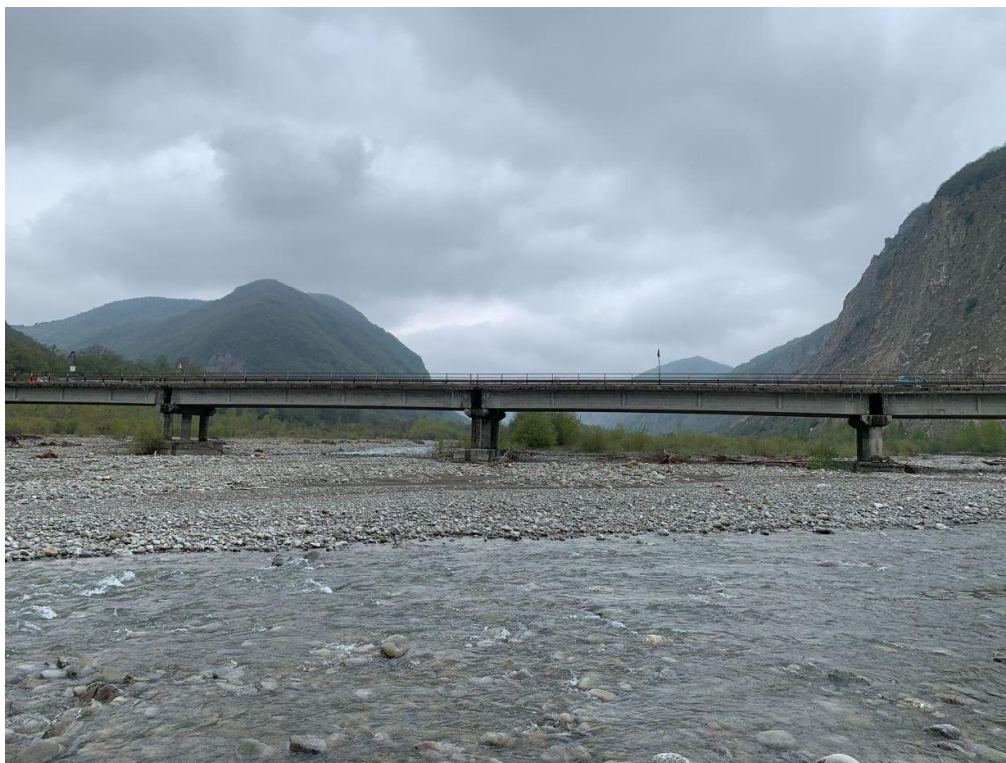
FOTO 3_Vista lato valle delle tre campate centrali
