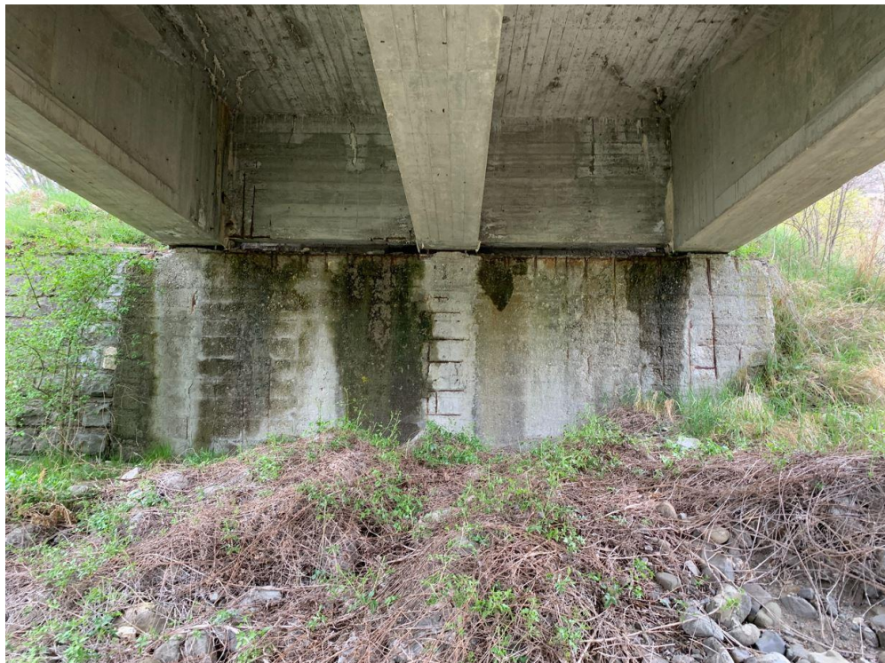
FOTO 4_Vista della spalla sul lato Castelnovo Monti
