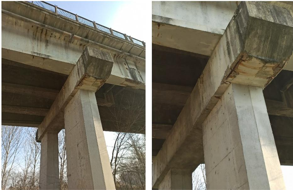
**Figura 5 - particolare pila con pulvino**
