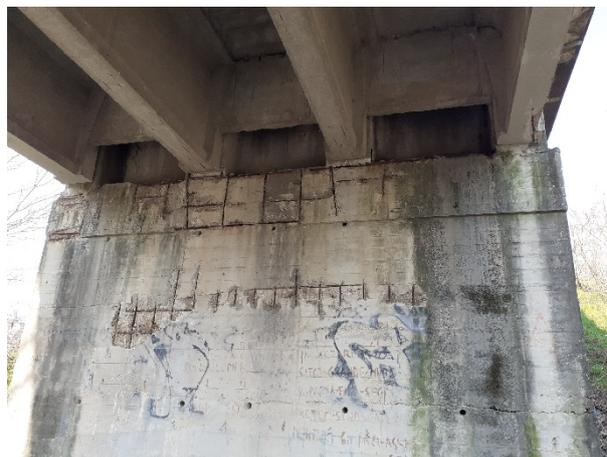
L'impalcato è del tipo Gerber modello "Kentucky" (Raithel, 1970) con travi principali a sbalzo dalle pile e travi tampone che poggia sugli sbalzi. La sezione trasversale è composta da travi prefabbricate a doppio T con soletta superiore in parte prefabbricata ed in parte gettata in opera (vedi tav. PONTE SUL PO TRA GUASTALLA E DOSOLO – PART. ARMATURA SOLETTA PREFABBRICATA TIPO 1 (INSIEME E SVILUPPO) disegno n° 1263-62 data 09-04-1966). Le travi principali sono collegate trasversalmente
