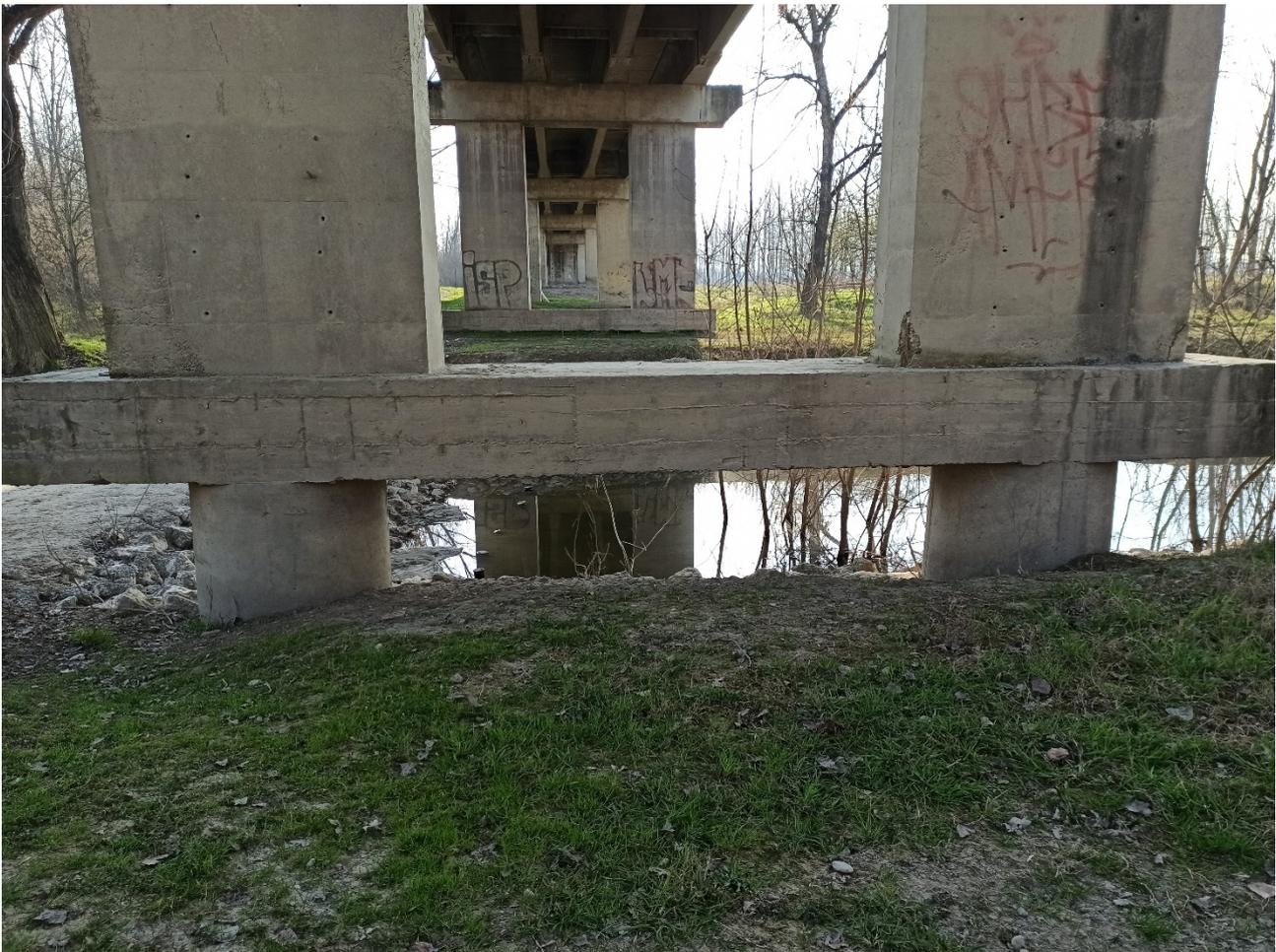
**Figura 4 - Pali di fondazione pile**
