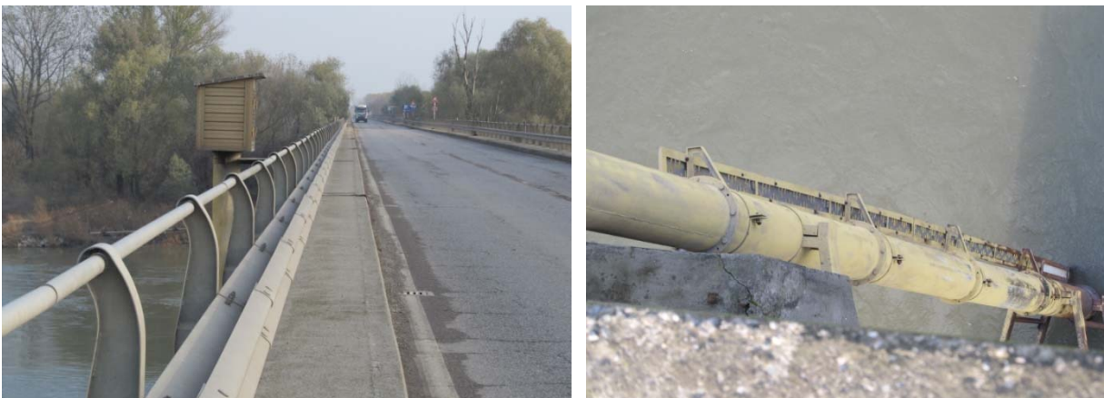
Figura 6.4: – idrometro AIPO presente sul lato di valle del ponte, al centro dell'alveo di magra
