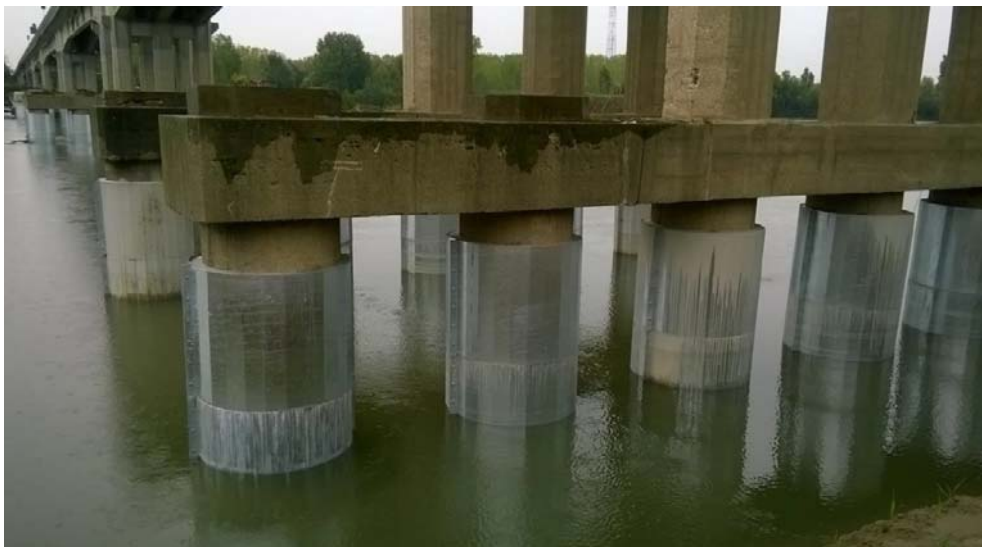
Figura 9.5: esempio di intervento di incamiciatura eseguito presso il ponte di Boretto (2017)
