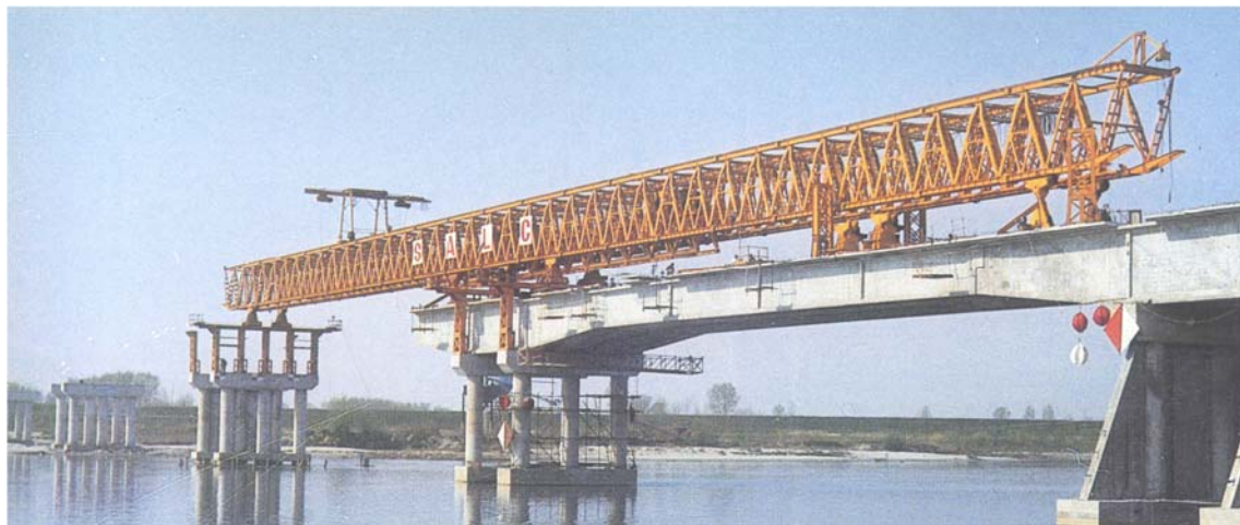
Figura 2.1: – Fase costruttiva (da foto d'epoca).
