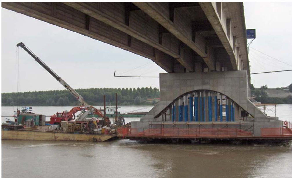
Figura 11.6: – foto con esempio di impiego di pontoni in ambito fluviale per intervento su ponte esistente
