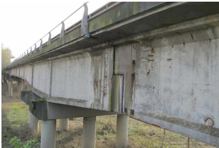
Figura 7.3: – ingrandimento su impalcato precompresso - tratto in provincia di Mantova
