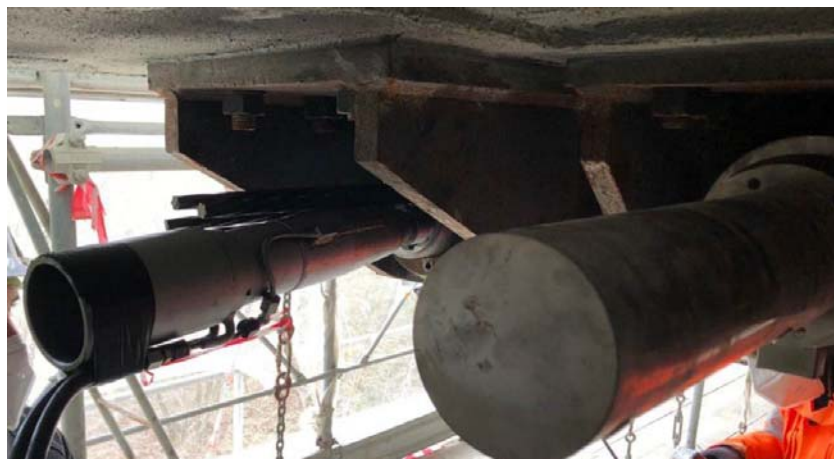
Figura 9.10: – Cavi di Post Tensione esterna per manutenzione viadotti – tesatura con martinetto monotrefolo
