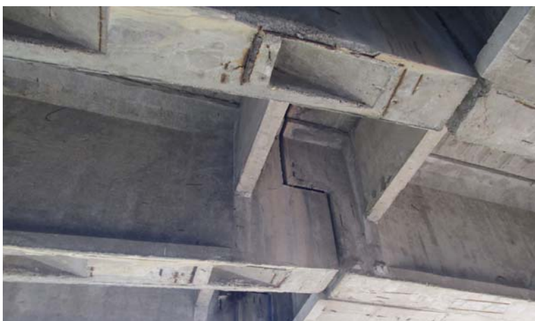
Figura 9.11: – sedi delle testate dei cavi di precompressione
