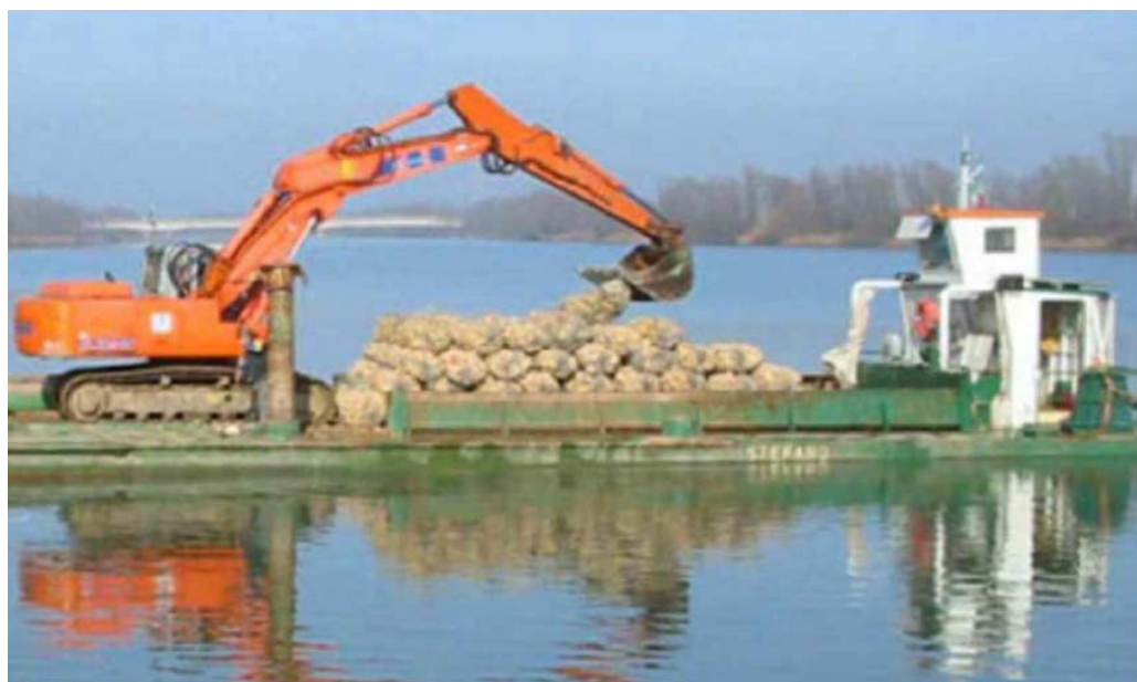
Figura 9.8: esempio di varo delle burghe da pontone
