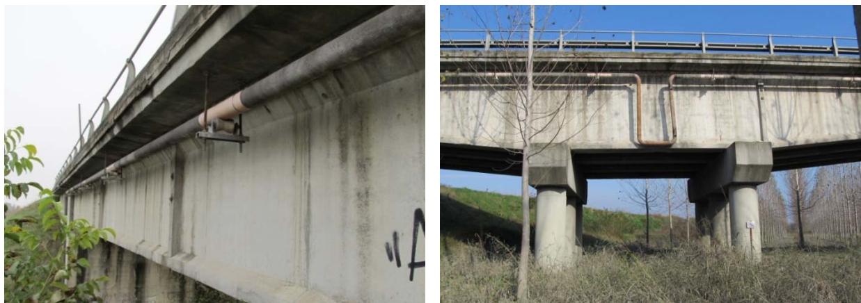
Figura 6.1: – condotta gas metano lato di monte (foto sx), giunto di dilatazione della condotta (foto dx)
