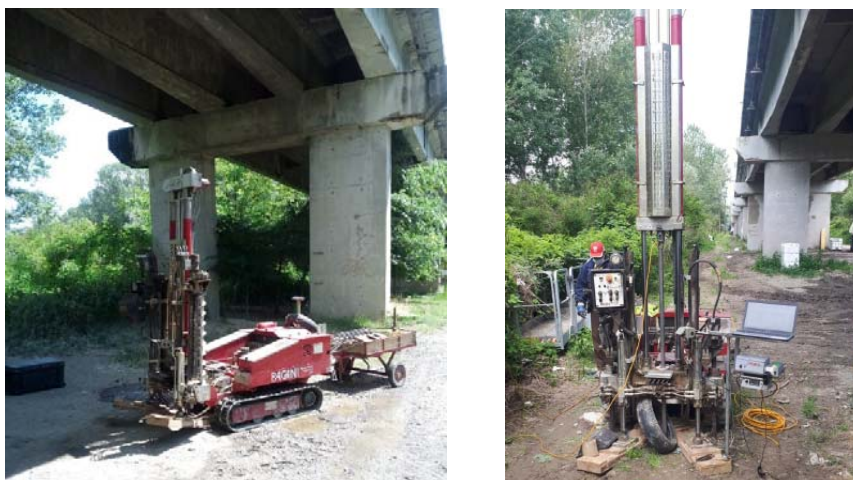
Figura 5.7: – foto delle prove penetrometriche eseguite nel giugno 2021
