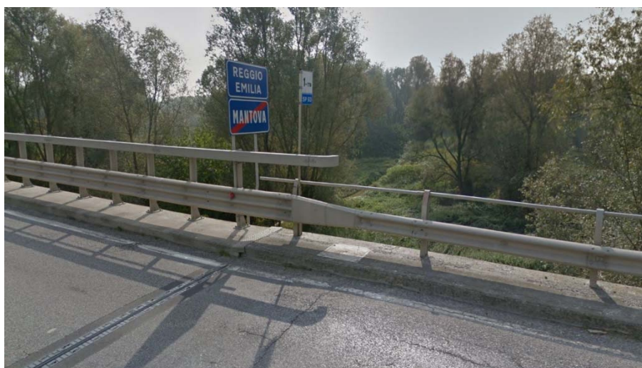
Figura 9.17: – foto del cambio di tipologia di barriera stradale
