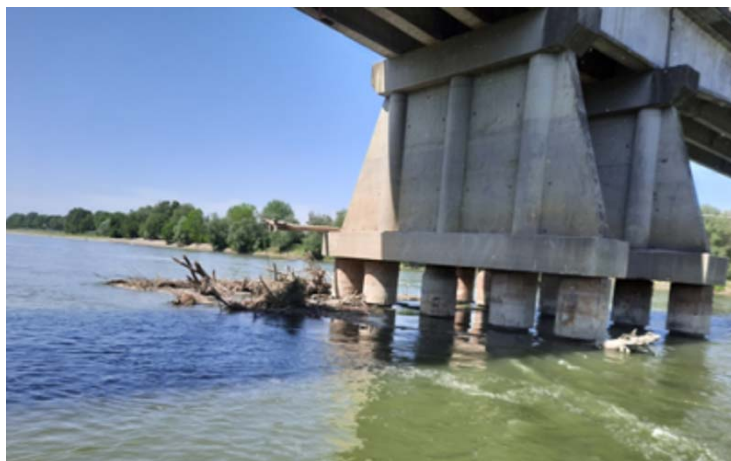
Figura 5.2: – pila 9 con accumulo di materiale in sospensione
