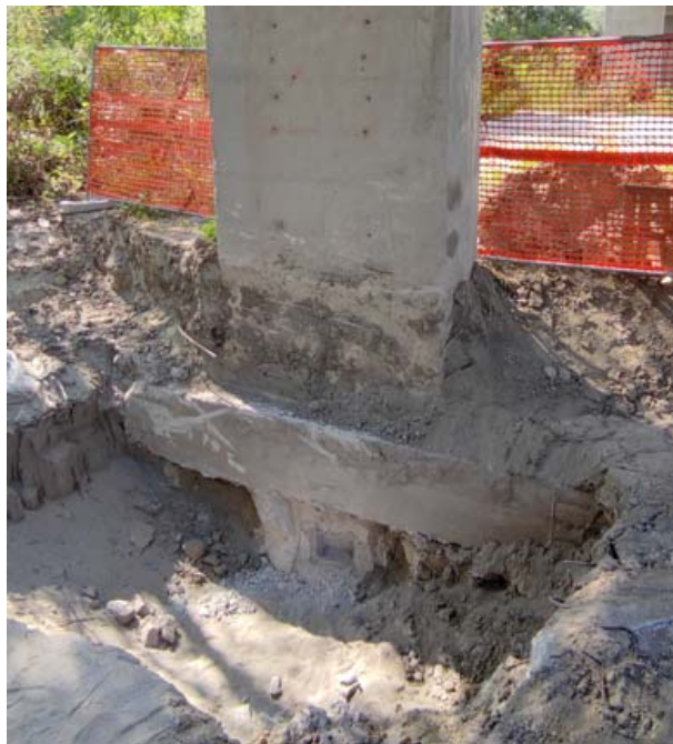
Figura 5.11: – preparazione nicchia per esecuzione prova ecometrica su un palo di una pila in golena reggiana
