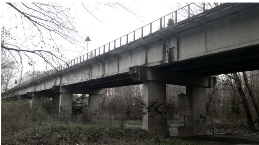
Figura 7.4: – viadotto in golena - tratto in provincia di Reggio Emilia
