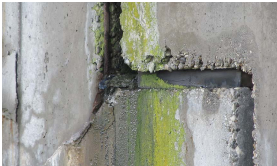
Figura 9.14: – foto di un appoggio presente sul tratto in alveo
