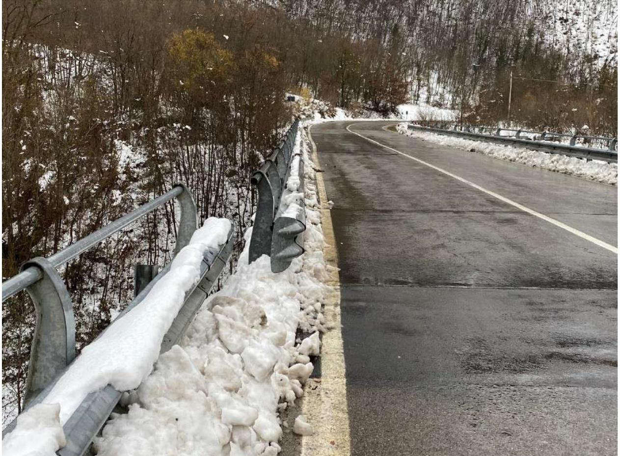
Figura 3 – Disallineamento guardrail
