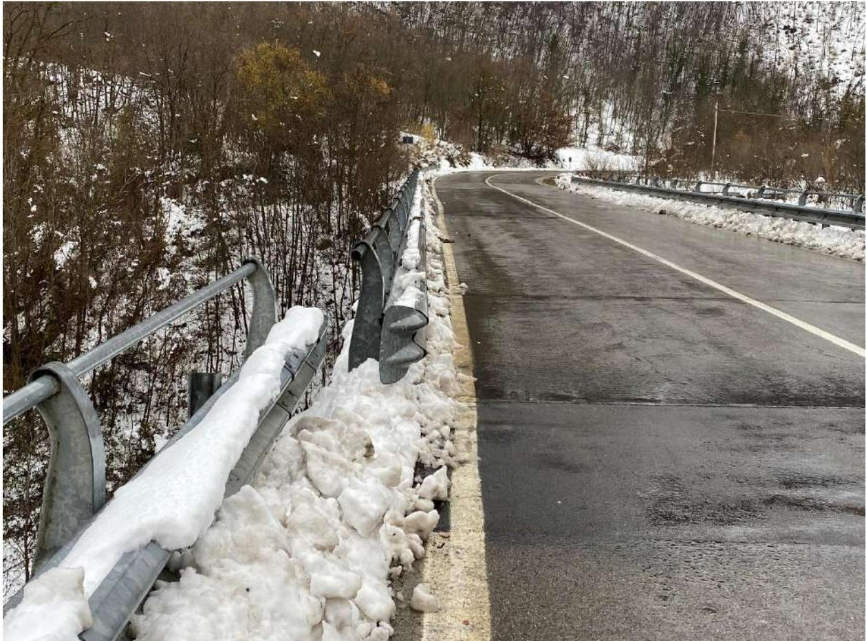
Figura 3 – Disallineamento guardrail
