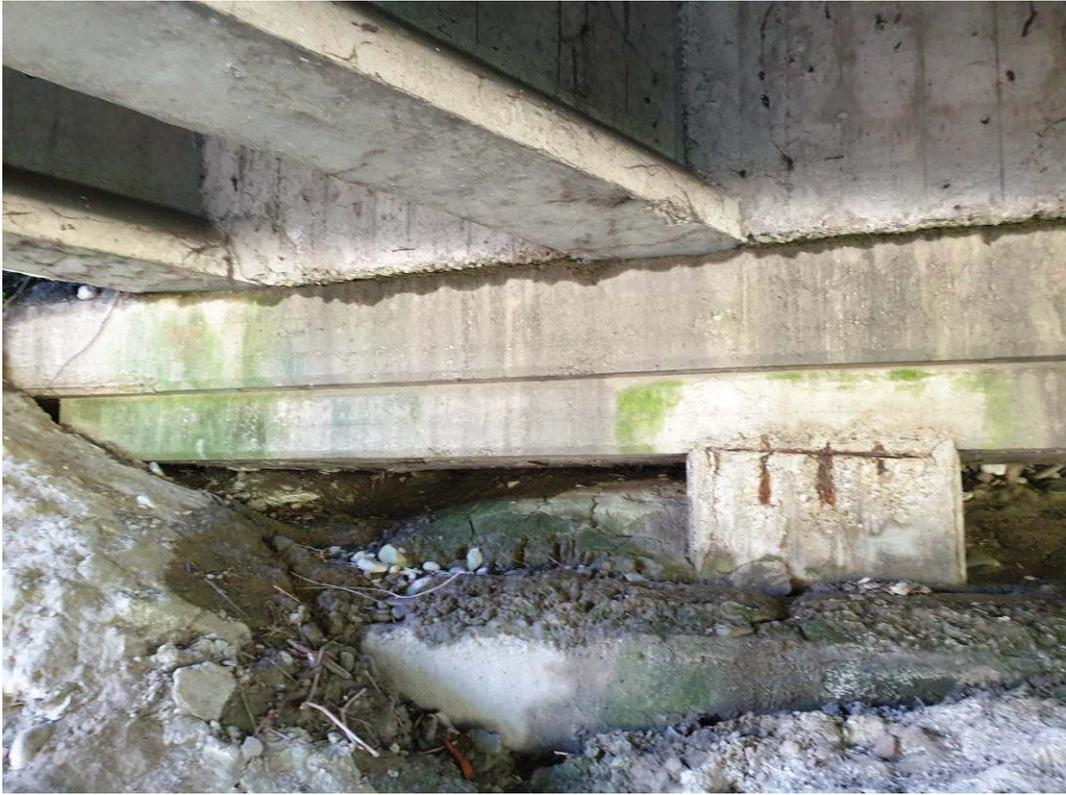
*Foto 9 – Dettaglio del degrado della spalla*
