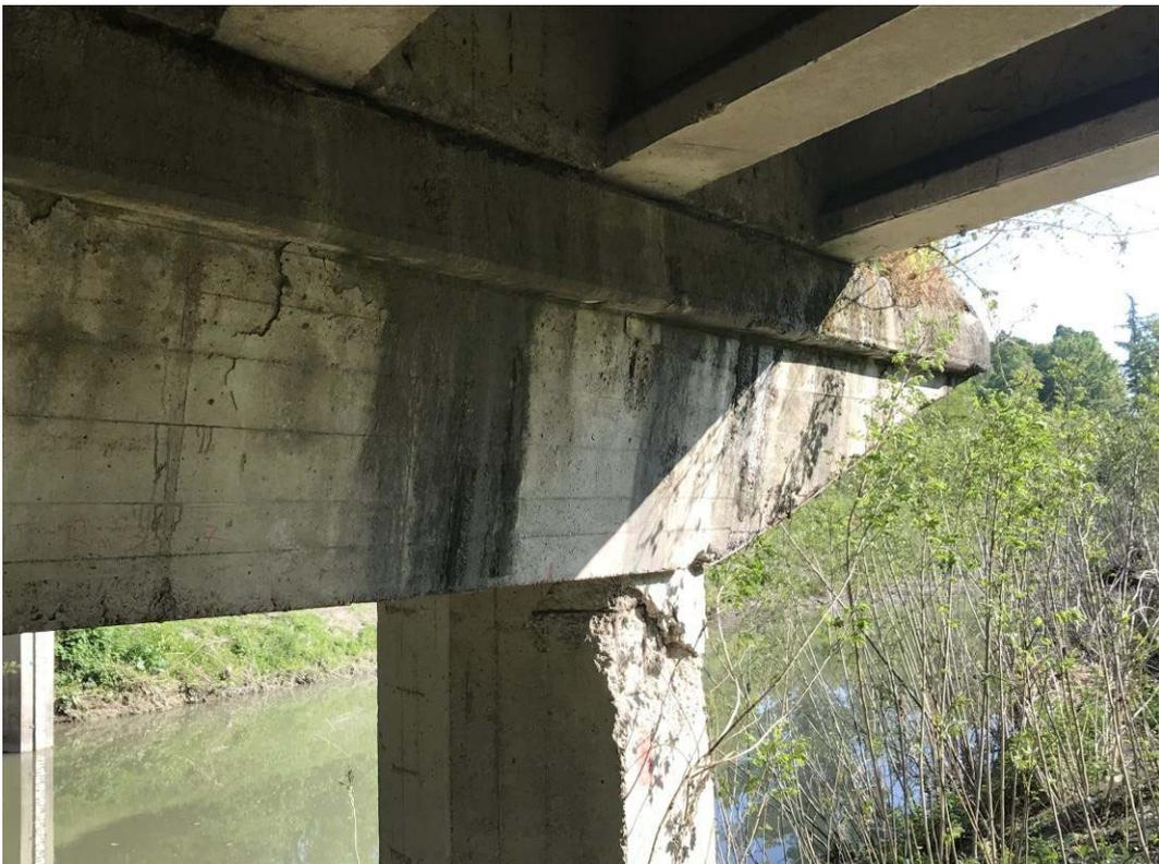
*Foto 8 – Dettaglio del degrado della trave pulvino e del pilastro*
