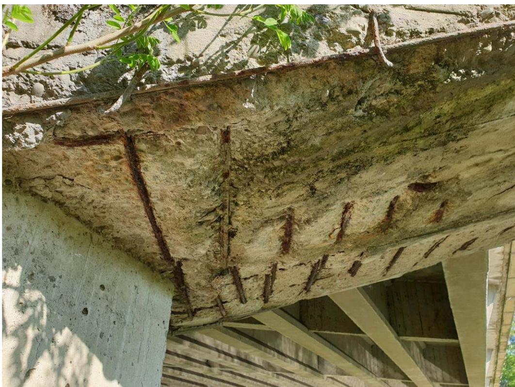
*Foto 6 – Dettaglio del degrado della trave pulvino lato valle*
